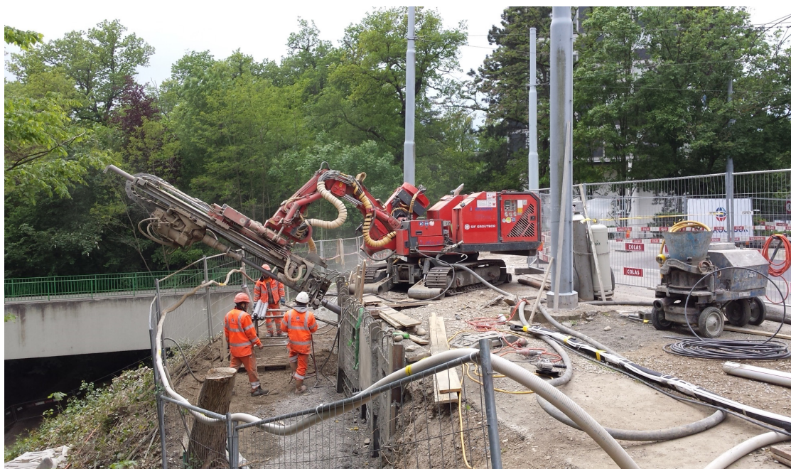
Mise en place des tirants d'ancrage pour la stabilisation du talus au pied de la boucle du Lignon
