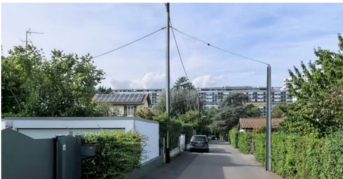
Figure 6 : éclairage public et ligne électrique existants
