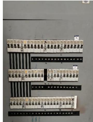
Les tableaux électriques de l'école ne sont pas dotés de système à différentiel, comme ce qui se fait aujourd'hui. Ce système permet de provoquer une coupure de courant lors d'une anomalie de tension due à un appareil défaillant, par exemple. Le changement de ces tableaux engendrera ainsi une augmentation de la sécurité des utilisateurs.
