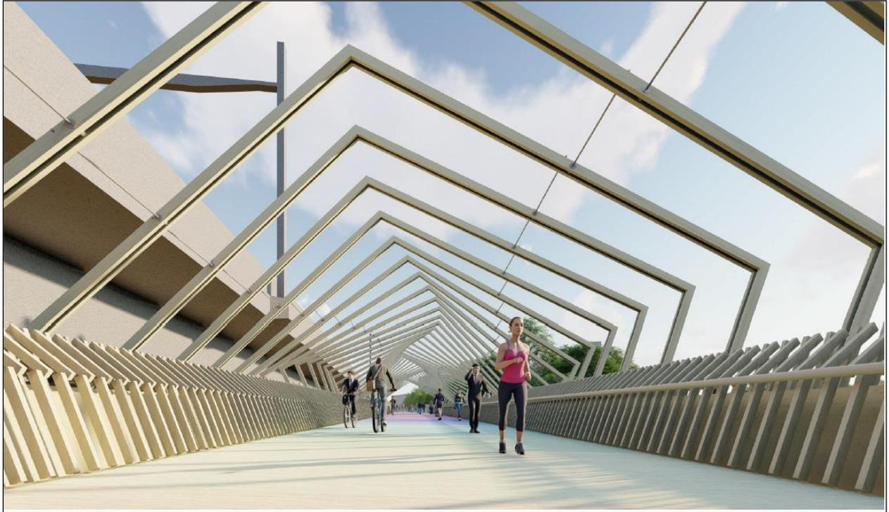
Figure 18. Architecture de la passerelle au-dessus de l'autoroute (proposition d'arches dont l'ensemble forme une sinusoïde
