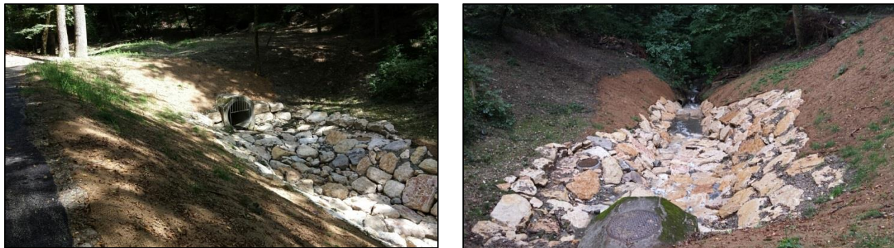
Figure 3. Km 0.451 – Nant des Grebattes – travaux réalisés en 2015
