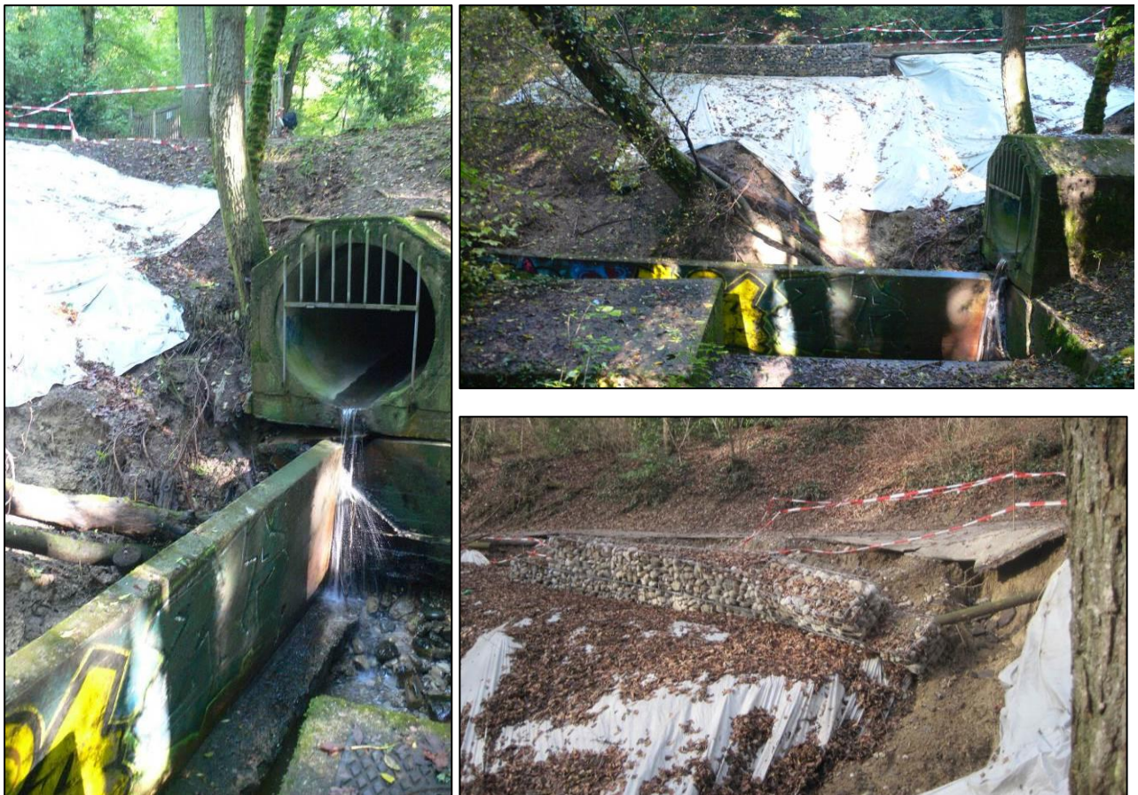
Figure 2. Km 0.451 – Nant des Grebattes – érosion des berges
