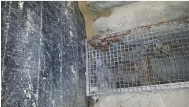
Sortie de l'écoulement de la fosse plongeoir du bassin olympique
