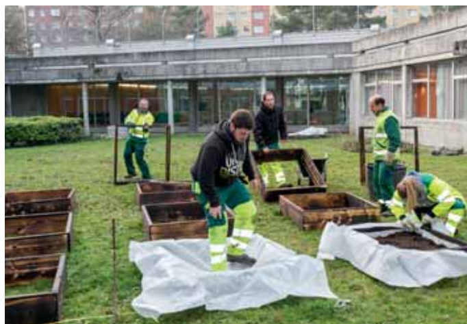
D'une hauteur de 25 cm, les bacs sont recouverts d'une toile géotextile pour retenir la terre et drainer l'eau.
