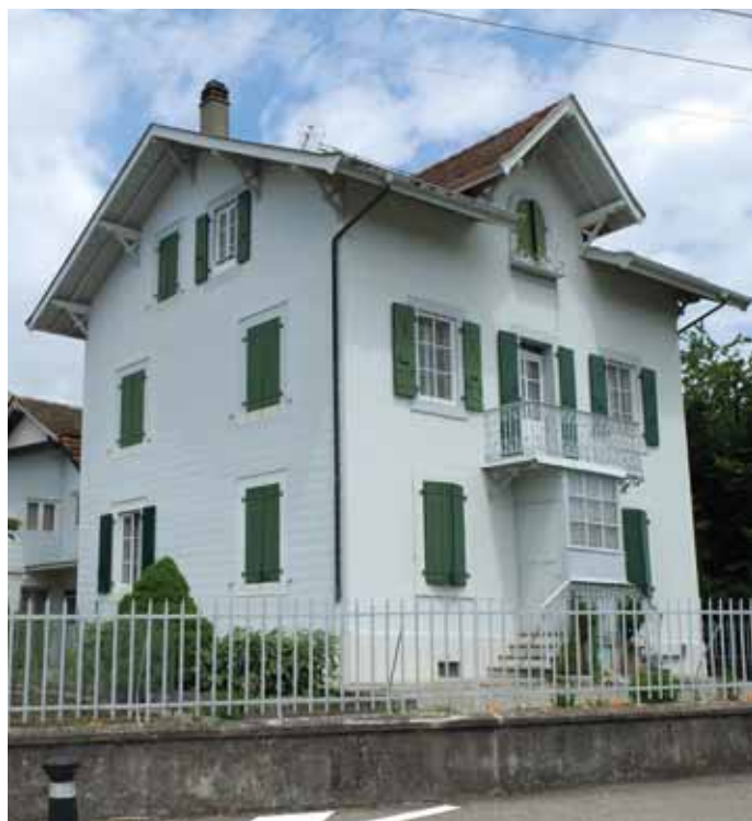
Villa bâtie en 1910 par les entrepreneurs Roch et Laplace, située le long du chemin des Vidollets.
