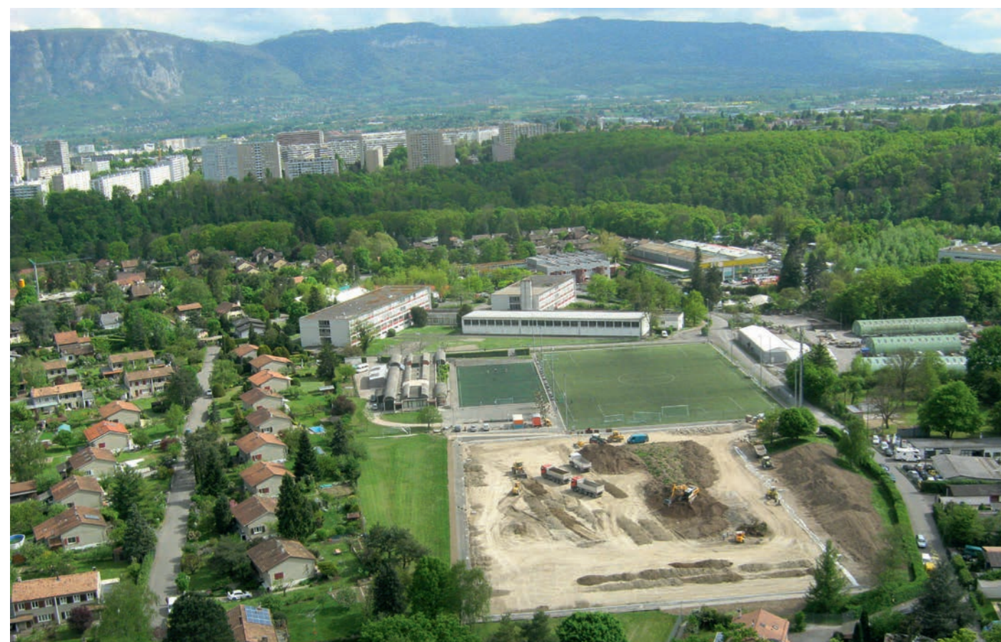
Travaux de rénovation du stade de football d'Aire.
