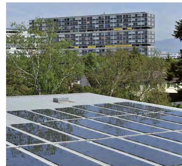
Le toit de l'école d'Aire.
