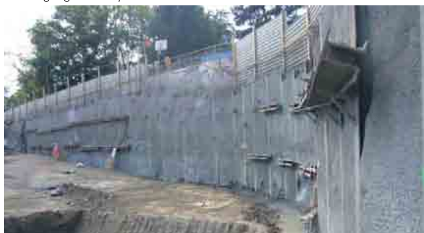
Paroi mini-berlinoise le long de la future rampe côté « Croisette »
