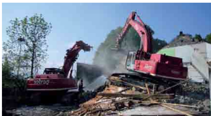
Démolition des bâtiments au chemin de la Renfile
