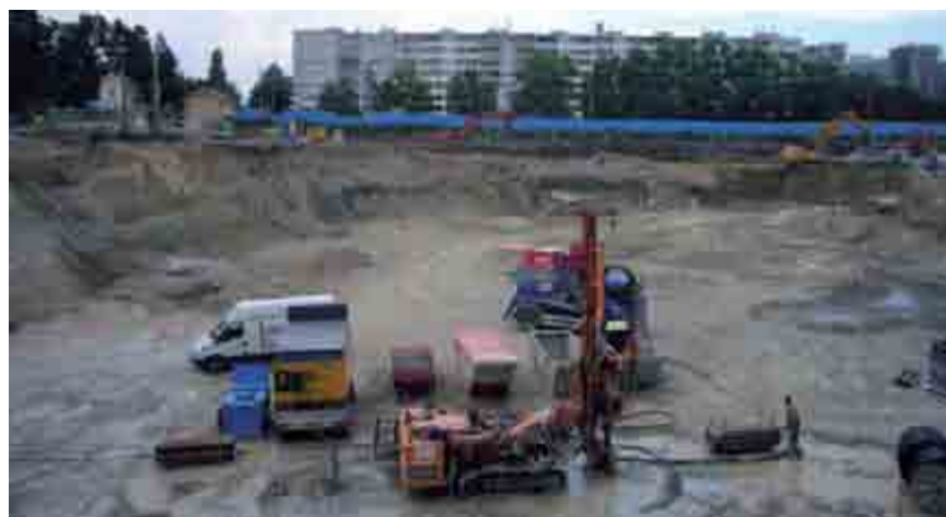
Les forages géothermiques
