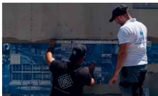
Pose des 200 carreaux de céramique au Lignon.
