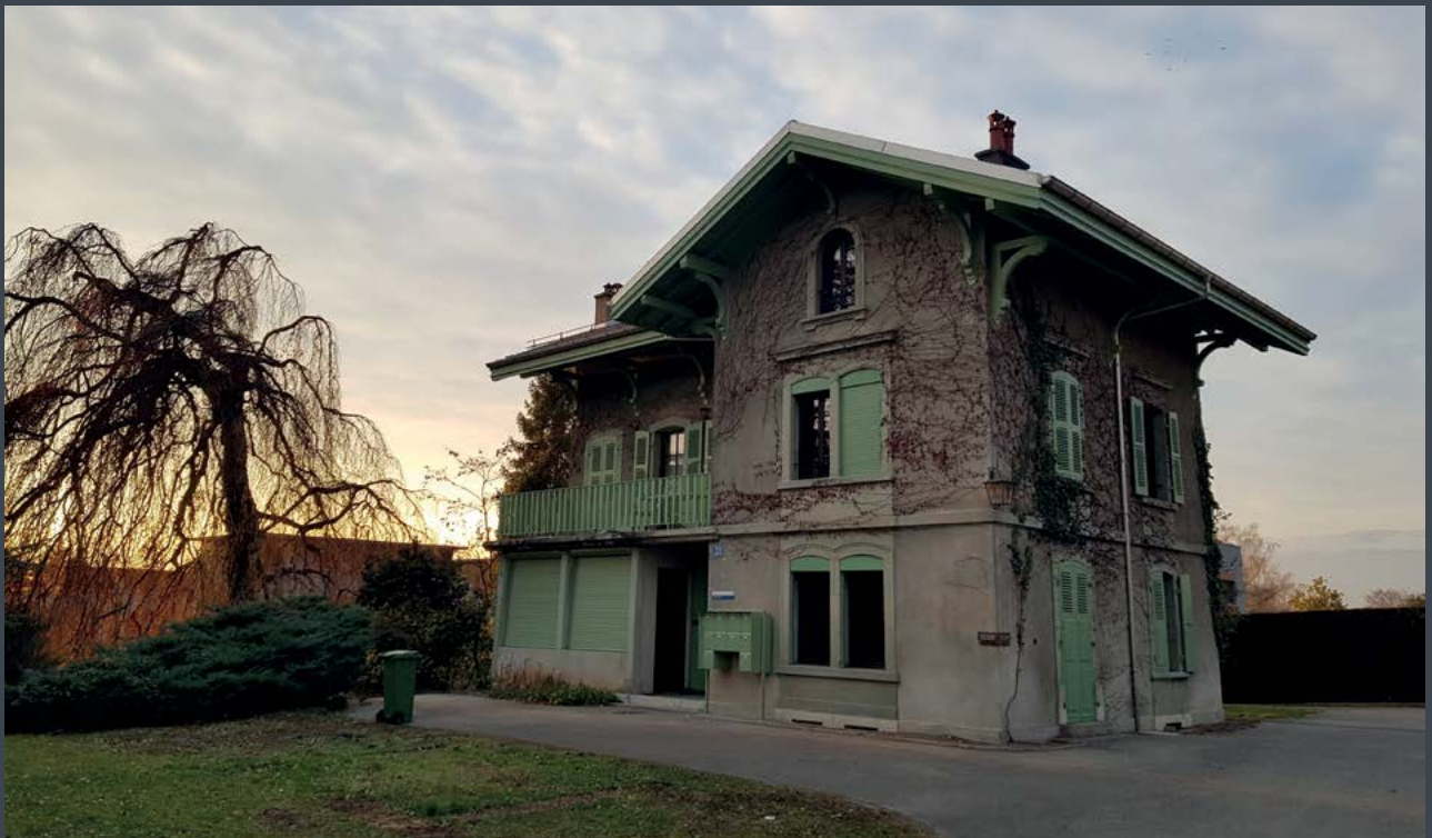
Maison 21 chemin des Coudriers après rénovation toiture et façades
