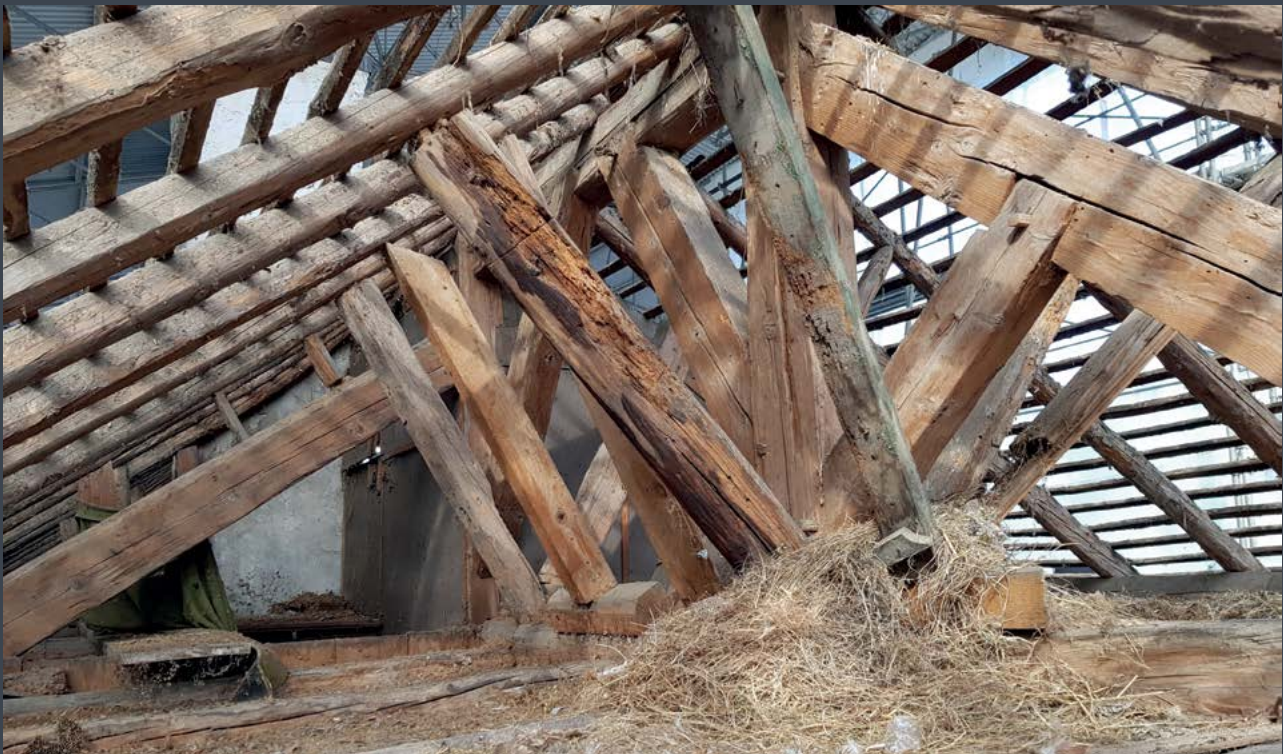
Maison d'Ivernois, rénovation de la toiture, éléments de charpente après découverte
