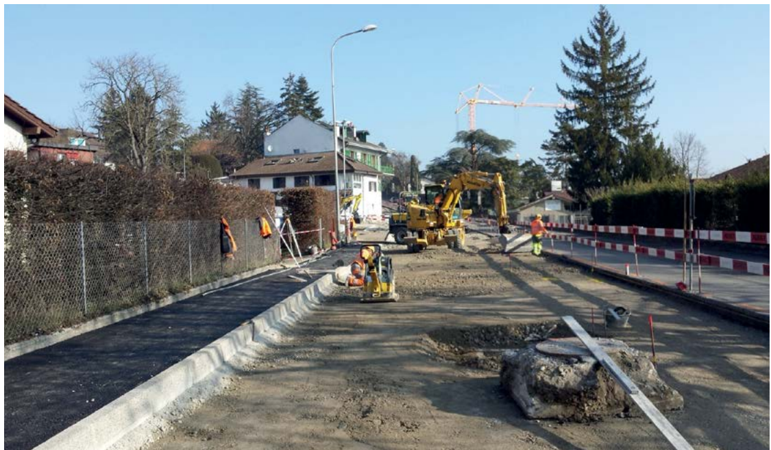
Travaux de réaménagement du chemin des Sellières
