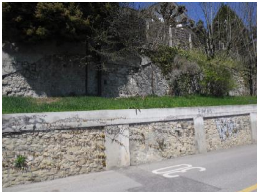
Figure 3 – création prévue de la cellule de réception du forage dirigé sur la zone engazonnée
